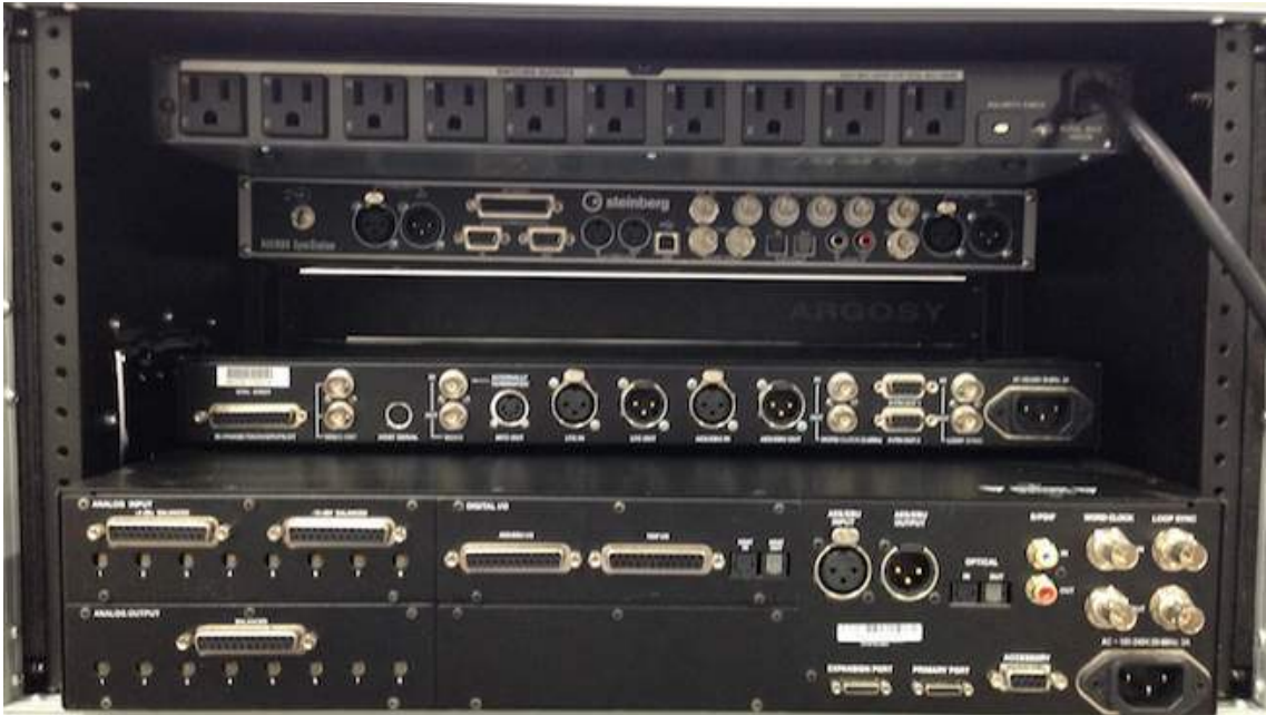
【Pro Tools System (rear) w/ SyncStation】
